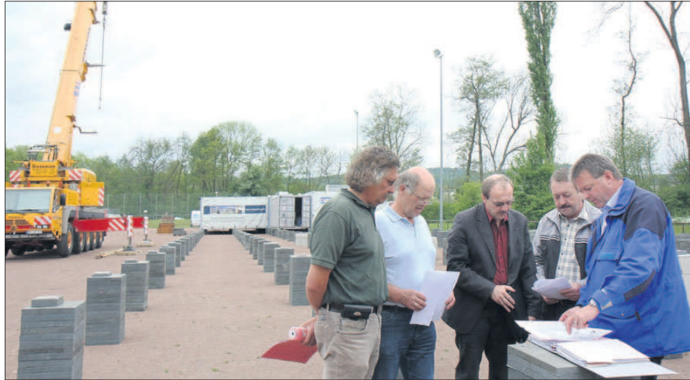
Der städtische Bauamtsleiter Klaus Hägele (rechts) hat gestern mit weiteren Beteiligten den Aufbau der Container für die Schule mitverfolgt. Bild: Pavlovic
